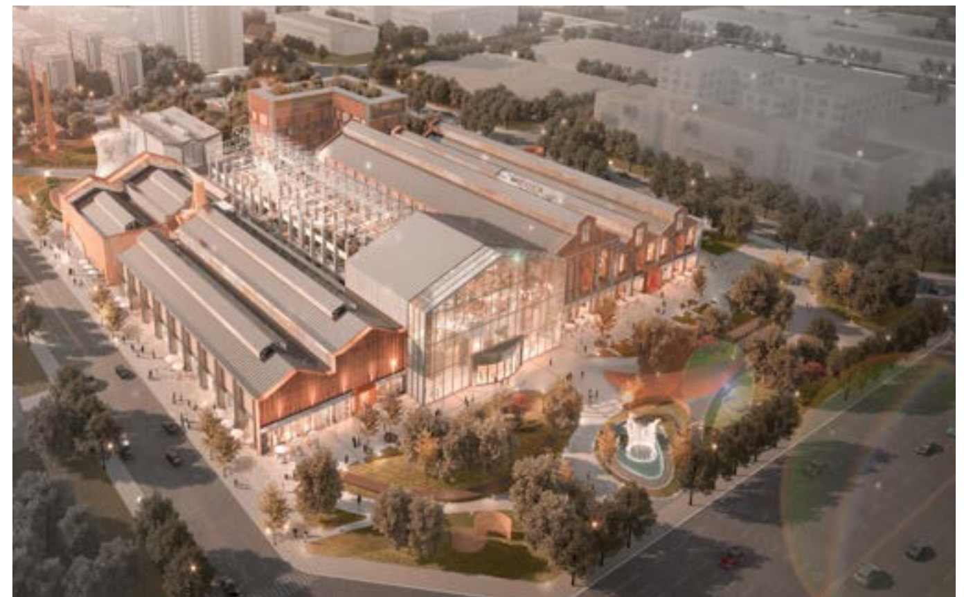
2020 IAF 锋建筑节·最佳大奖（工业类）《工业遗产与科技文明的握手：机车厂厂房改造设计》城市更新事业部
